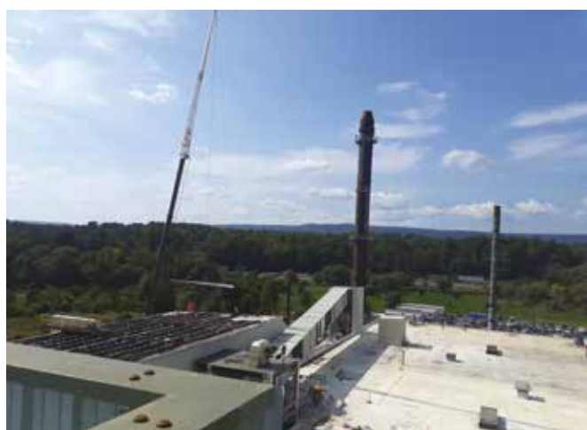
Slika 5: Pogled na gradbišče
