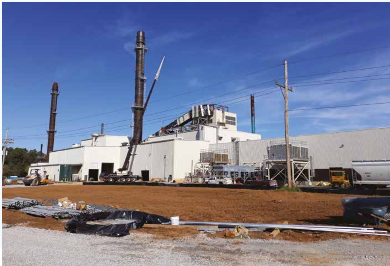
Slika 2: Gradnja objekta v zaključni fazi
