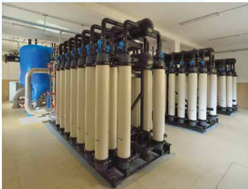
Ultrafiltracijska naprava z navpično postavljenimi moduli – 130 l/s
