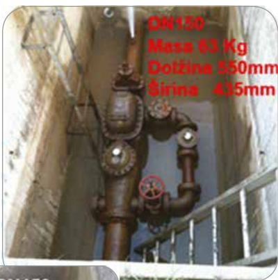
Montaža mehanskega merilnika
