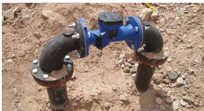
Nemehanski – montaža »brez omejitev« v praksi
