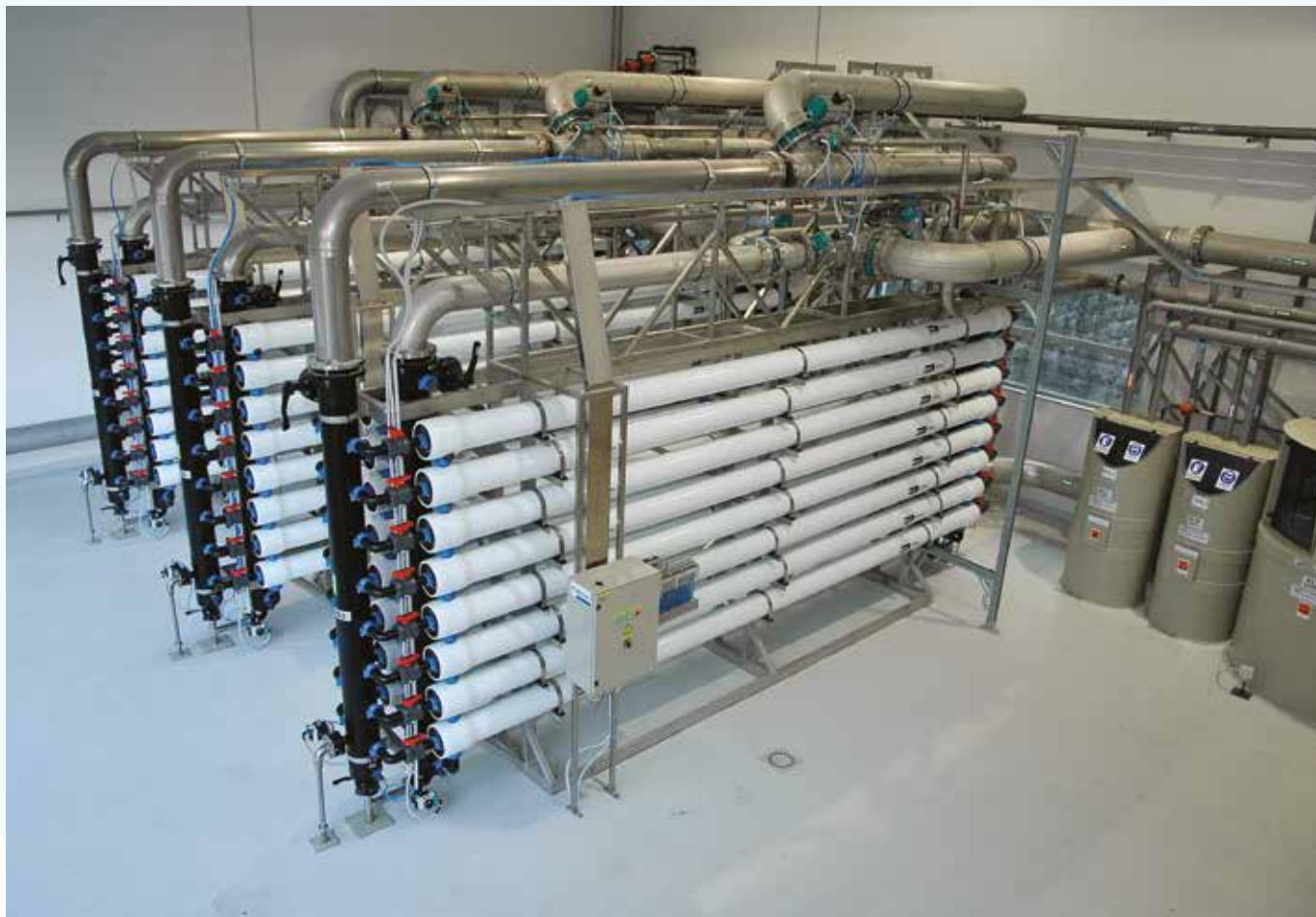
Ultrafiltracijska naprava z vodoravno postavljenimi moduli – 150 l/s
