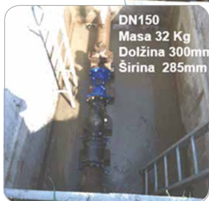
Montaža nemehanskega merilnika
