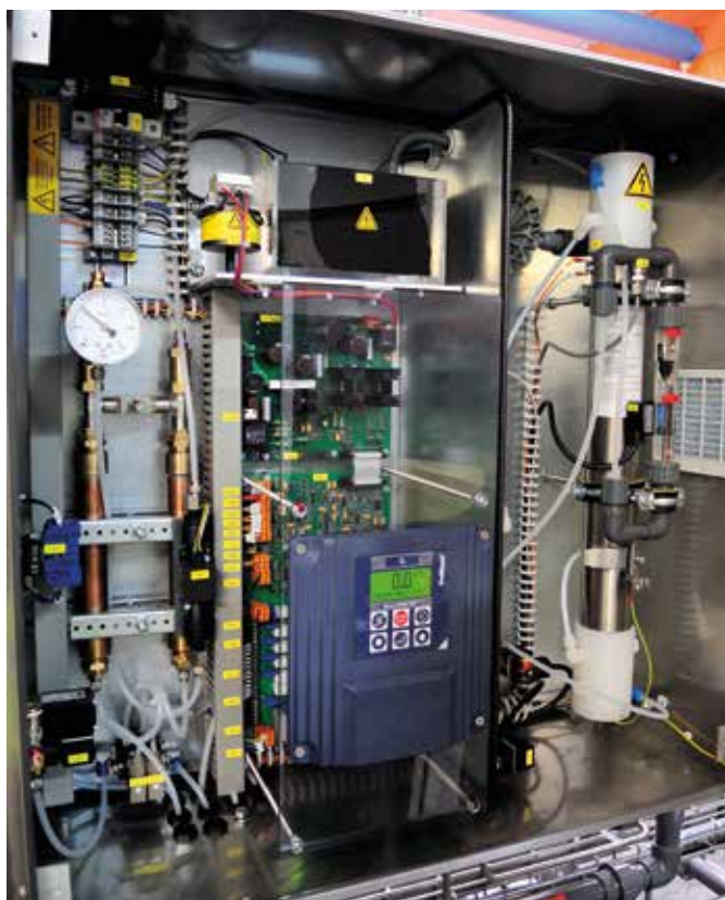
Slika 3: Notranjost generatorja ozona: levo – sušilnik zraka, desno – celica za generacijo ozona
